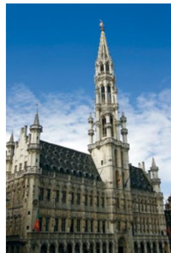
Budynek brukselskiego ratusza
